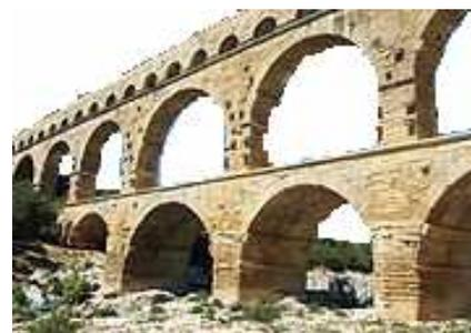
L'aqueduc proprement dit témoigne de la maîtrise des constructeurs romains : le dénivelé entre les points de départ et d'arrivée n'est que de 12,6 m, la pente moyenne générale étant de 24,8 cm par km. Le dénivelé était fixé avec un outil, le *chorobate*.
